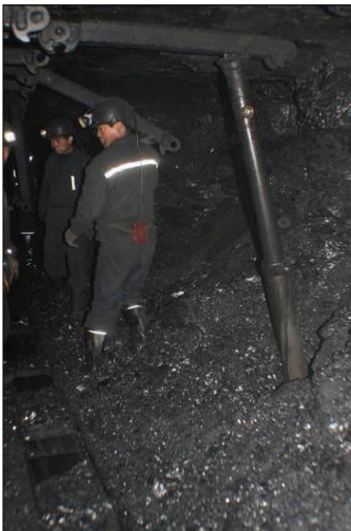
圖5-6：大雁煤礦長壁式半機械化採區
