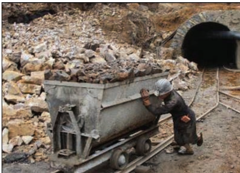
圖5-2：在建中的興和煤礦斜井
