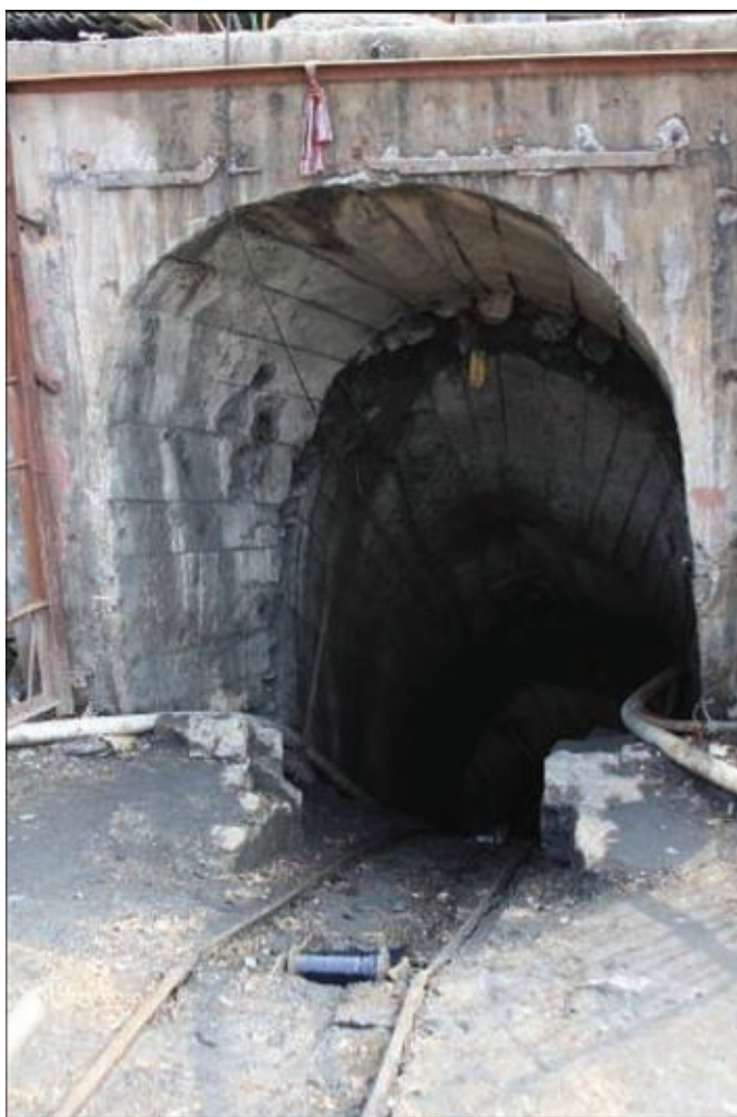
圖5-5：廬山煤礦斜井
