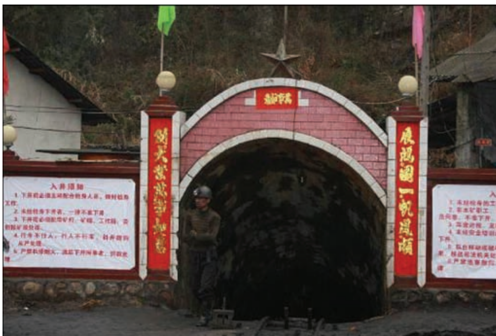
圖5-1：鐵沖煤礦斜井
