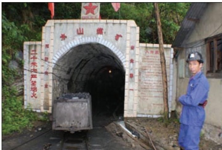
圖5-3：水山煤礦斜井口礦車
